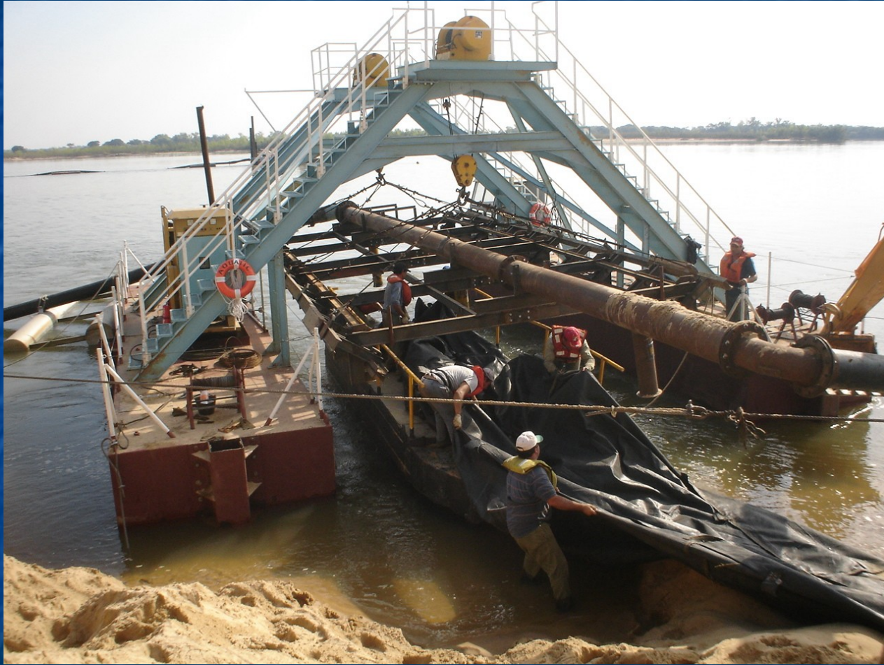
Equipo para colocación de geotubos
