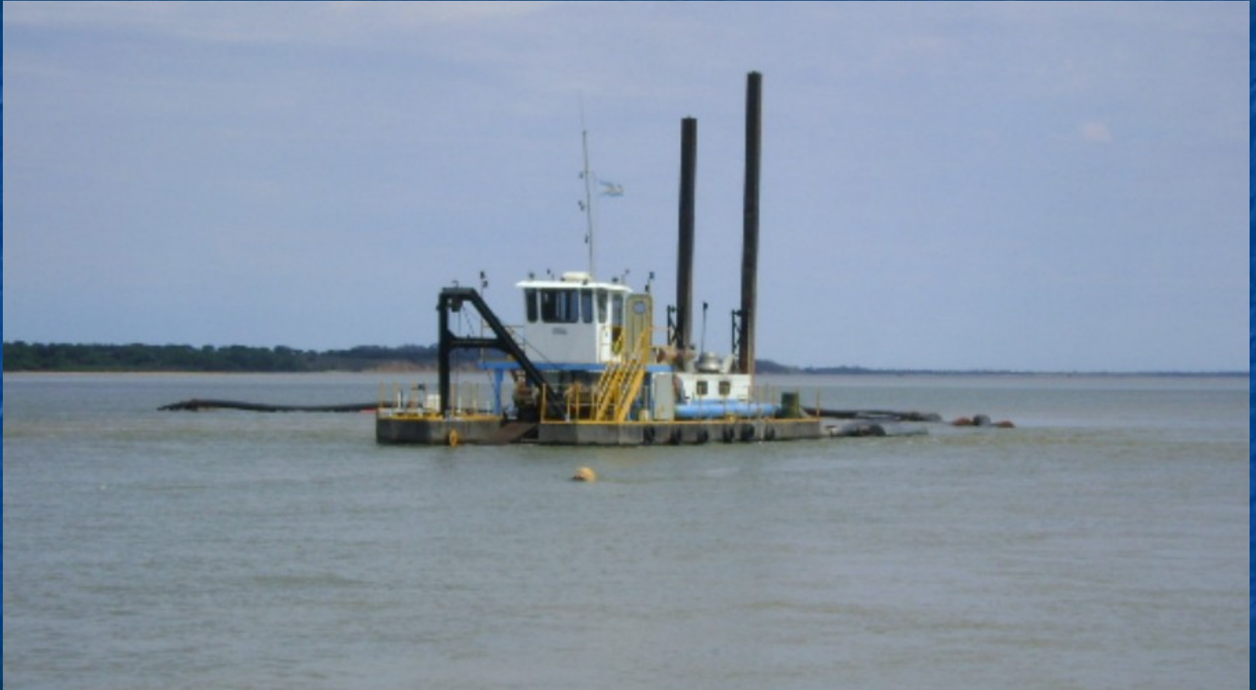
Dragado del canal de alivio
