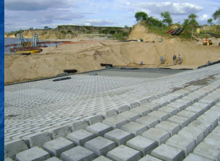
Colocación de manta de bloques de hormigón
