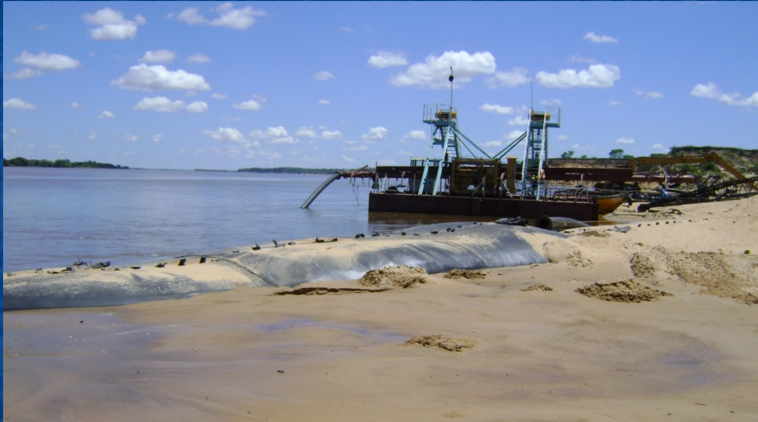
Geotubos en el río
