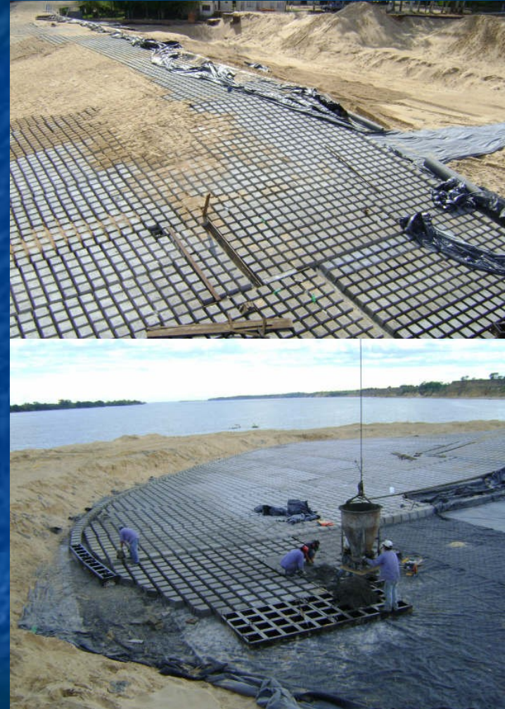
Construcción de manta de bloques de hormigón
