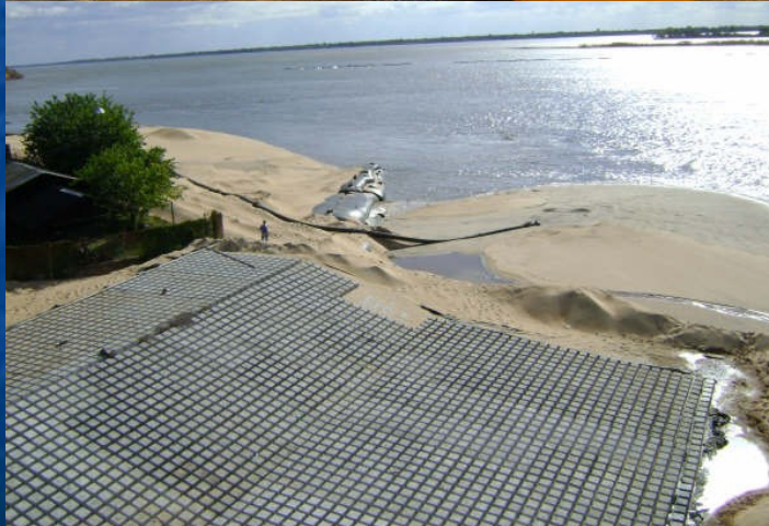
Colocación de manta de bloques de hormigón
